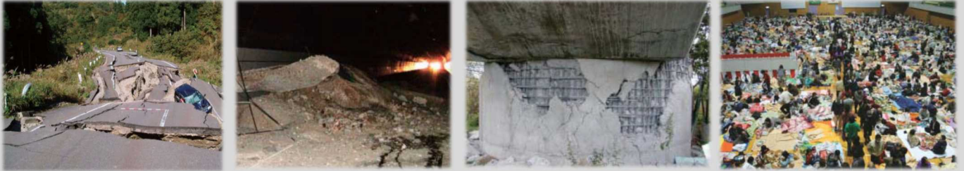
写真：左から、陥落した国道253号（旧新潟県堀之内上稲倉）、国道17号和南津トンネルのコンクリート剥落、国道17号小千谷大橋橋脚被の破損、被災3日目の避難所
